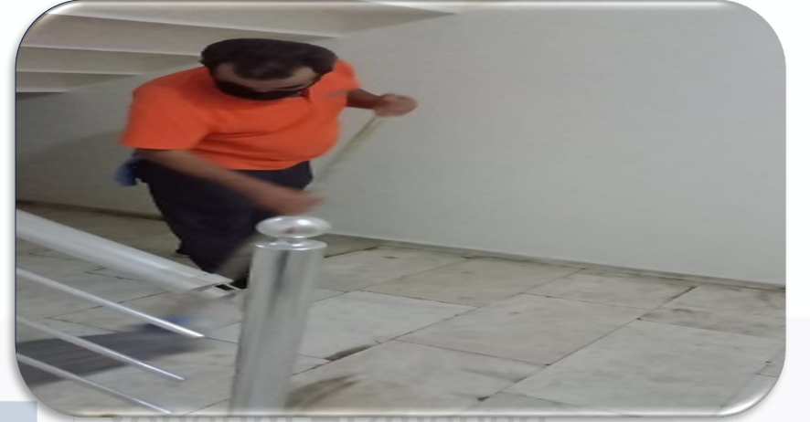
Bina geneli ortak alan koridor zemin temizliđi gerekleřtirilmiřtir.
