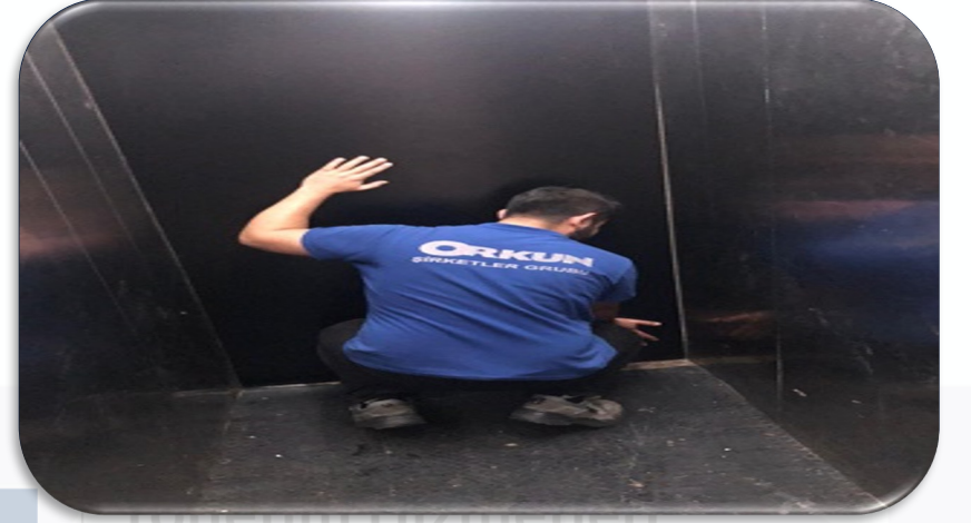
A Blok yk asansrnn kompozit koruma levhası yenisi ile deęiřtirilmiřtir.
