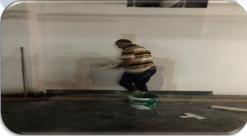
Kapalı otopark hasarlı duvarları tadilat işlemleri gerçekleştirilmiştir.
