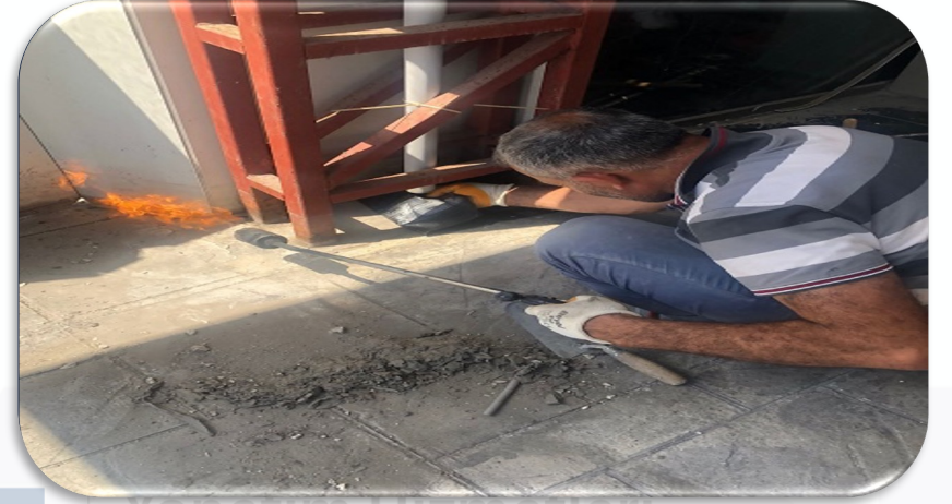
B Blok giriş alanı izolasyon kontrolleri sağlanmış,izolasyon eksiklikleri giderilmiştir.
