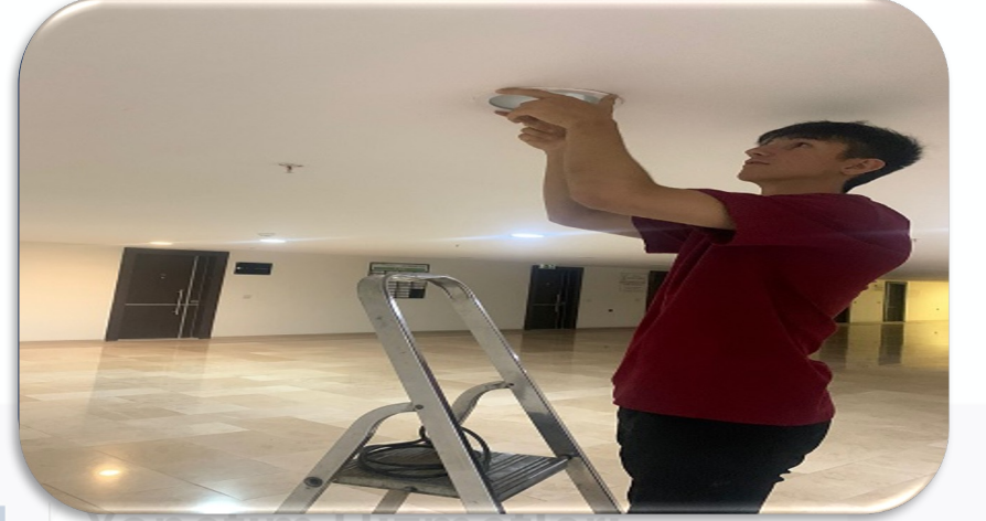
Bina geneli aydınlatma hasar kontrolleri gerçekleştirilmiştir.
