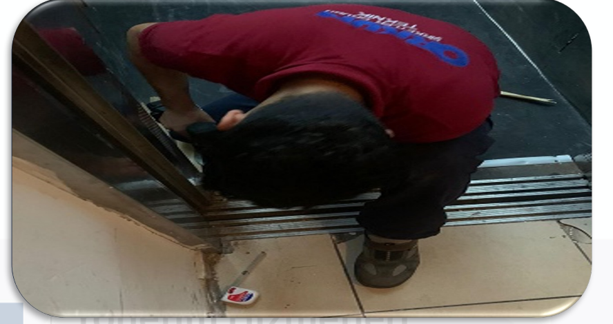
A Blok yük asansörü zemin kauçuk paspası yenilenmiştir.
