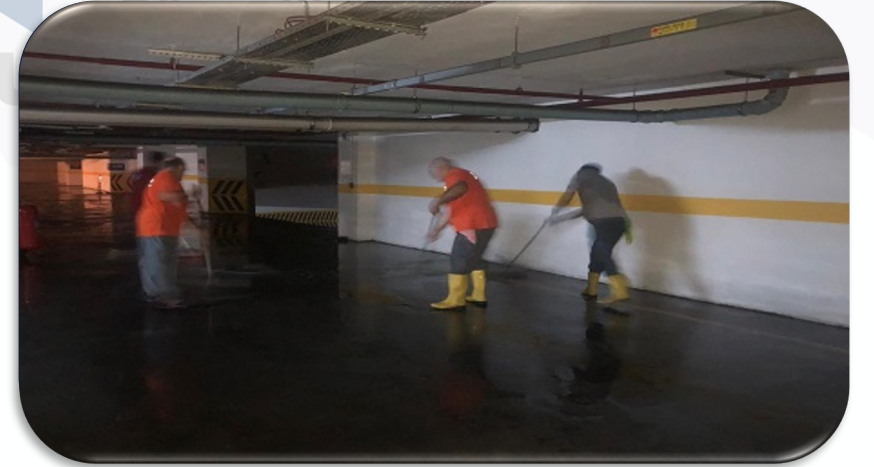
Kapalı otopark katları yıkanmıřtır.
