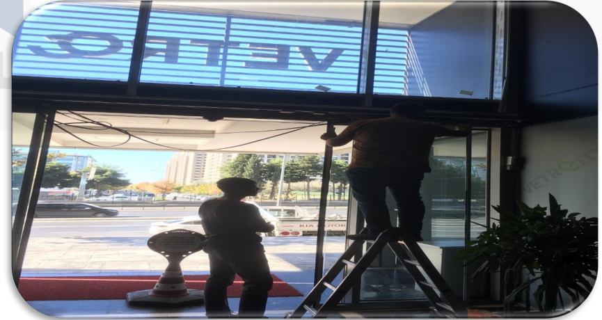
B Blok giriş kapısı arızalı motor mekanizması yenisi ile değiştirilmiştir.
