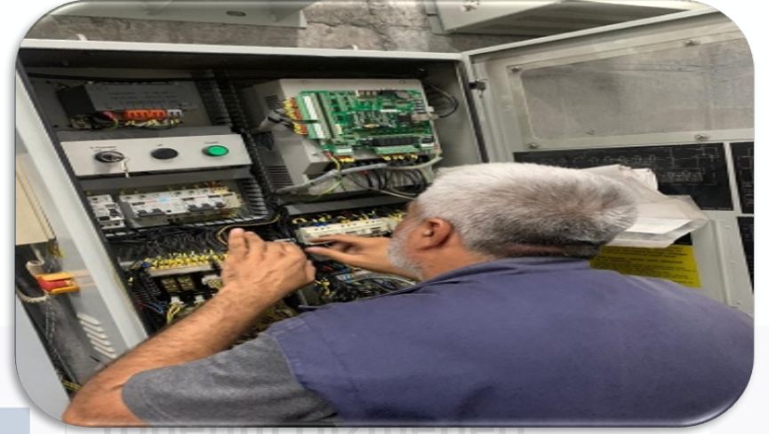
A Blok sağ asansör inverter tamiri gerçekleştirilmiştir.
