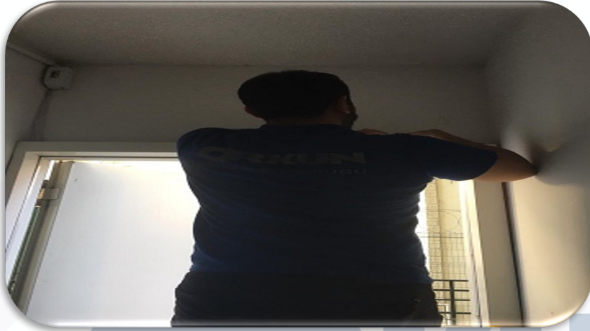
A Blok yük asansörü lobi çıkışıdaki manyetik kilidin hasar kontrolleri gerçekleştirilmiştir.
