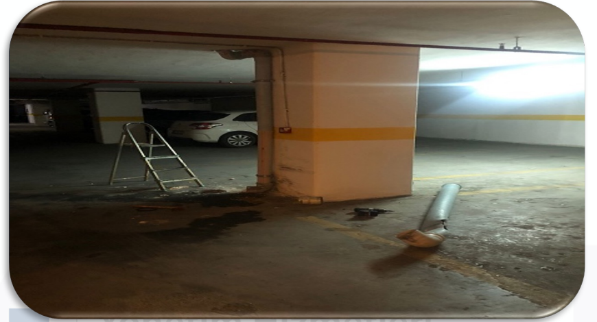
-3 kapalı otopark katındaki hasarlı yağmur suyu toplama pimaşı yenisi ile değiştirilmiştir.
