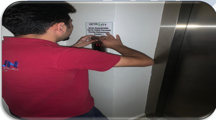
Asansör kat gösterge panellerinin hasar kontrolleri gerçekleştirilmiştir.
