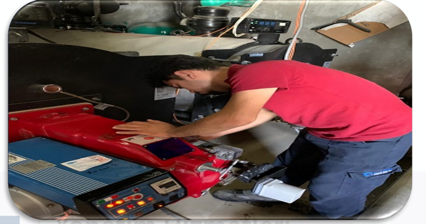
Isıtma sistemi periyodik kontrolleri gerçekleştirilmiştir.
