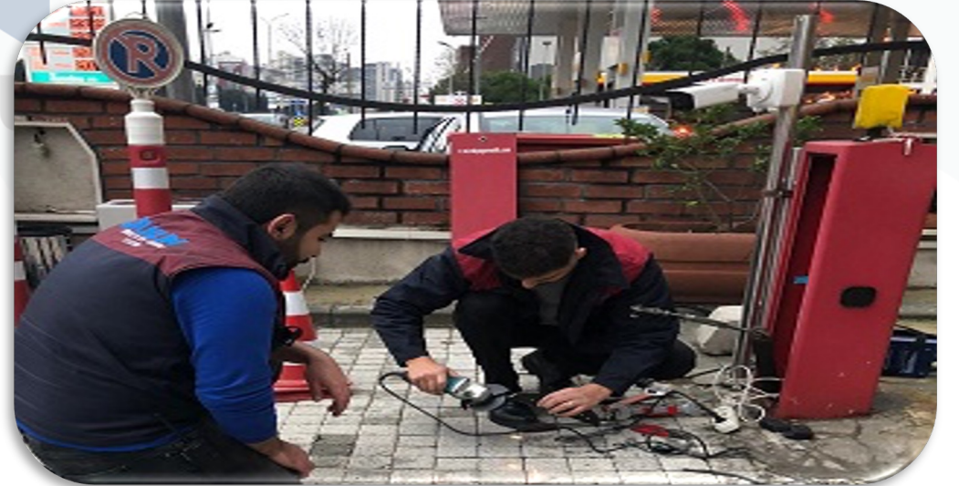
Otopark giriş bariyer motorunun kırılan mili değiştirilmiş, montajı gerçekleştirilmiş ve bariyer aktif hale getirilmiştir.
