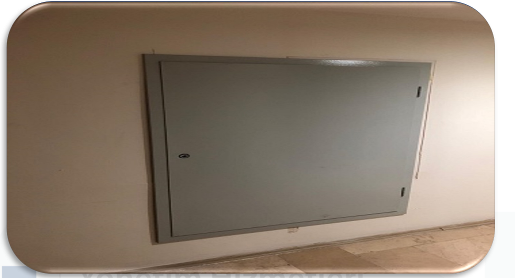
Ortak alandaki şaft kapakları yangın yönetmeliği kapsamında değiştirilmiştir.
