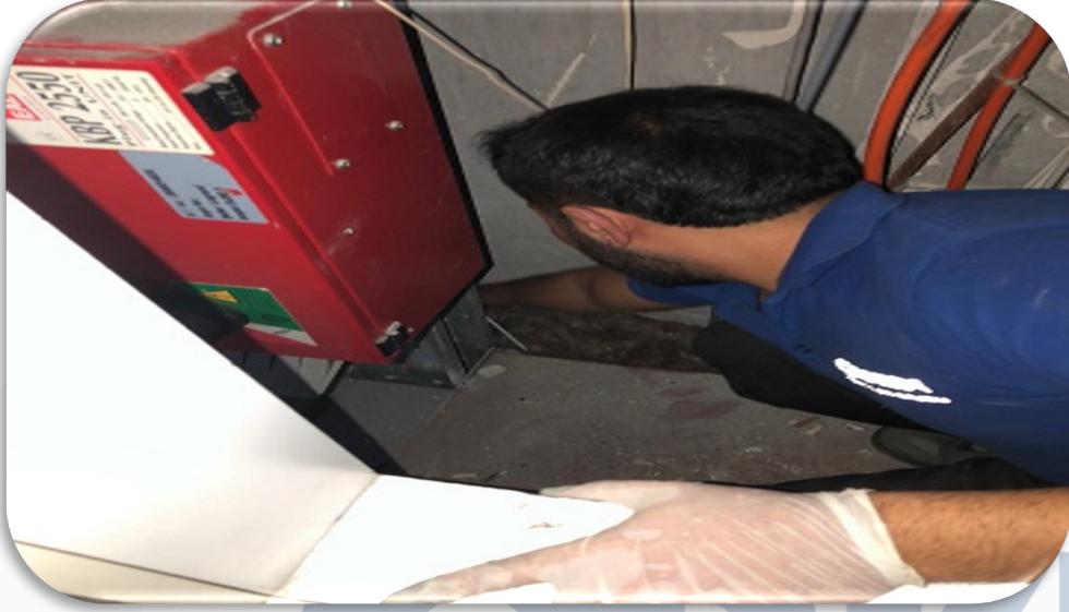
Bina geneli şaft boşluklarının iç kısmına taş yünü uygulaması yapılmıştır.
