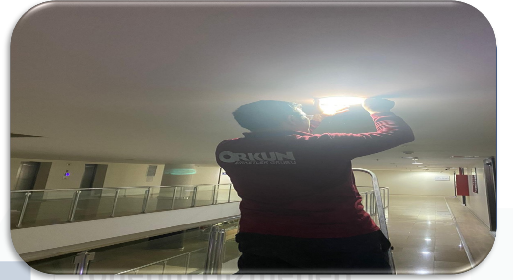
Bina geneli aydınlatma hasar kontrolleri gerçekleştirilmiştir.
