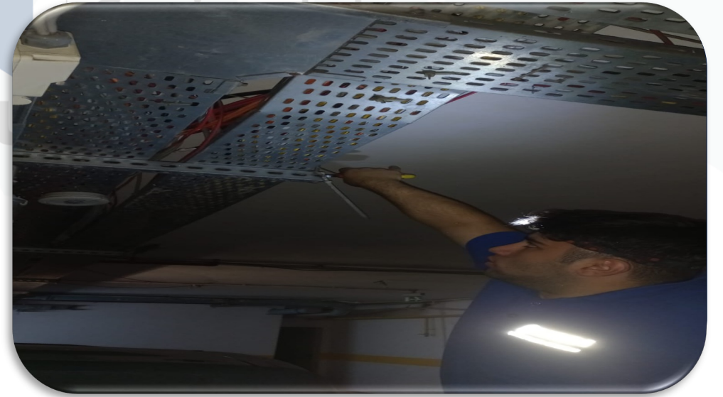
Ortak alan kablo kanalı kontrolleri sağlanmıştır.
