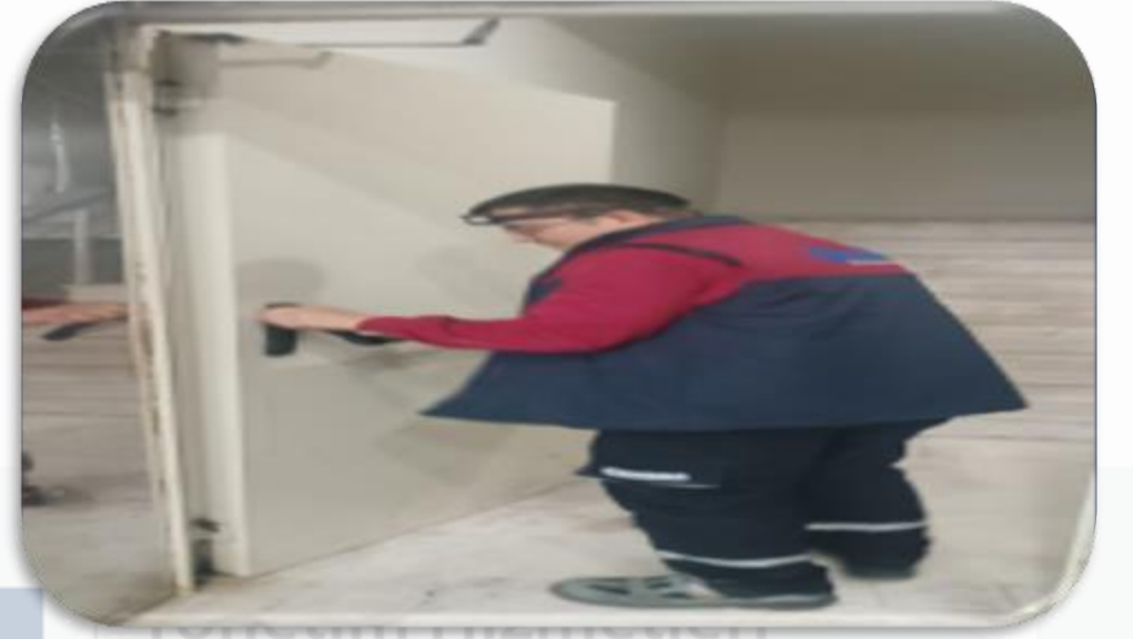
Bina geneli acil çıkış kapılarının genel kontrolleri sağlanmıştır.
