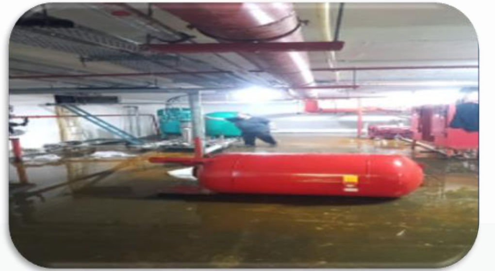
Hidrofor sistemi arızalı genişleme tankı yenisi ile değiştirilmiştir.
