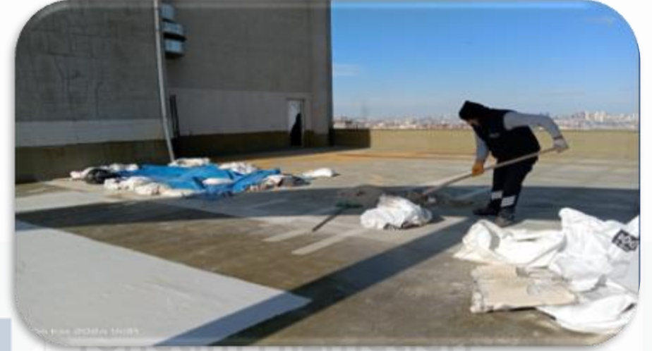
atı zeminindeki lokal izolasyon alıřması sonrası atı temizlięi gerekleřmiřtir.
