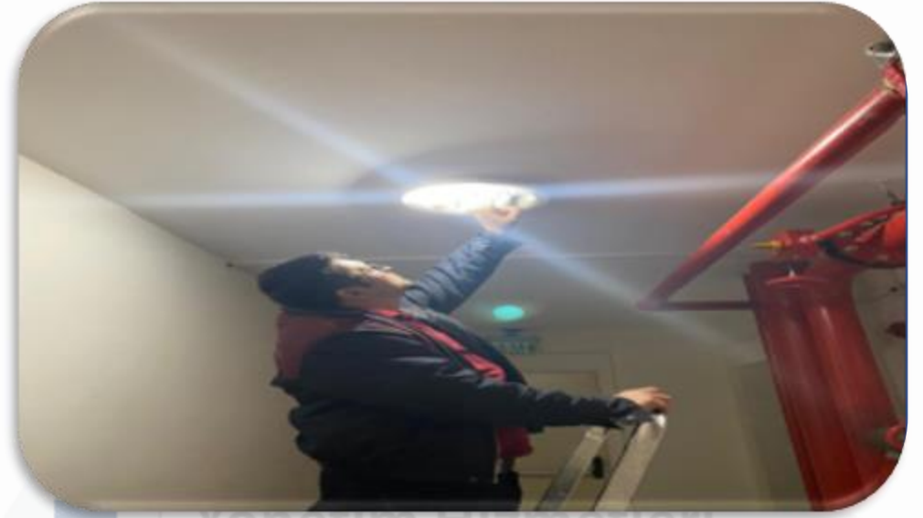
Bina geneli aydınlatma kontrolleri sağlanmıştır.
