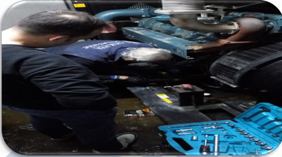
Jeneratör arızaları giderilmiş ve malzemeli bakımları gerçekleştirilmiştir.
