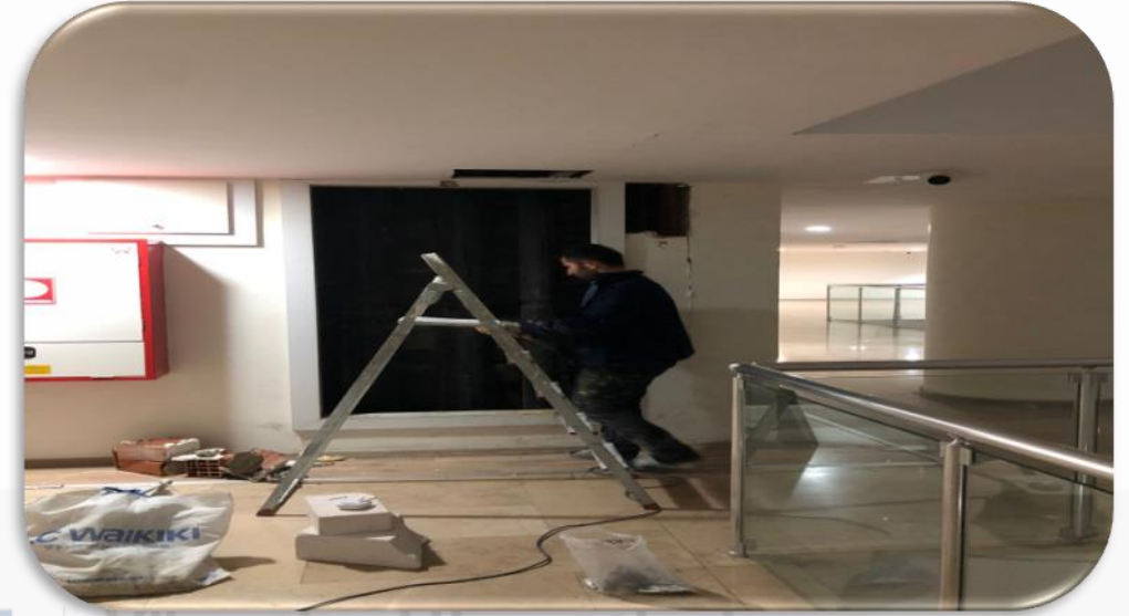
Isıtma sistemi sıcak su dönüş hattı kaçakları sonrası oluşan hasarlar giderilmiştir.
