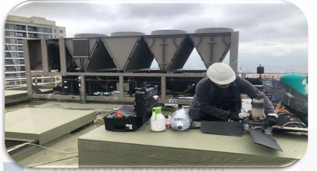
Soğutma Sistemi açılış ve kapanış bakımları gerçekleştirilmiştir.
