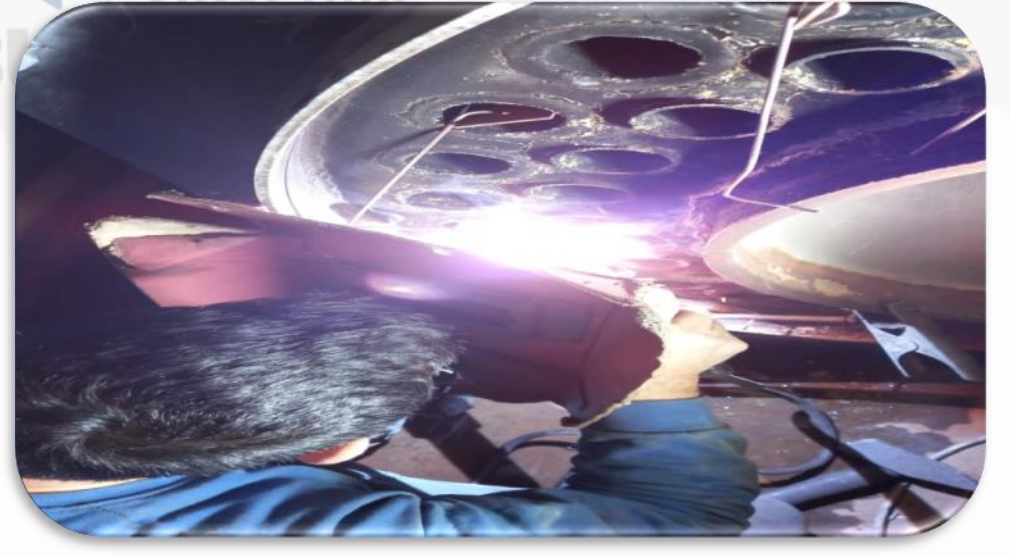
Isıtma sistemine ait boru çatlağı tamir edilmiştir.
