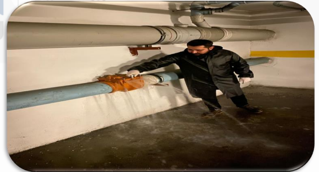
Kapalı otopark katlarındaki yağmur suyu toplama pimaşlarının kaçak kontrolleri gerçekleştirilmiştir.
