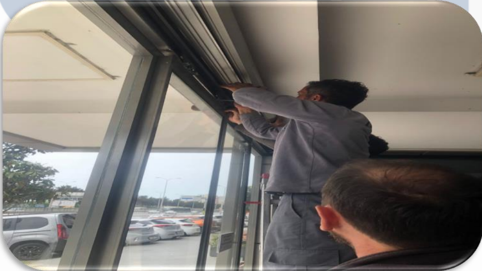
Bina giriş kapılarının periyodik bakımları gerçekleştirilmiştir.
