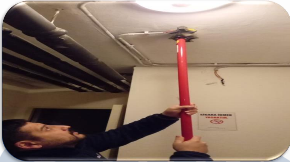
Yangın algılama sistemi periyodik kontrolleri sağlanmıştır.
