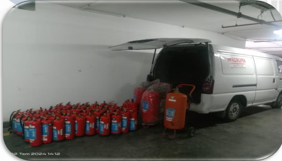
Yangın tüplerimizin periyodik dolum-bakım faaliyeti gerçekleştirilmiştir.
