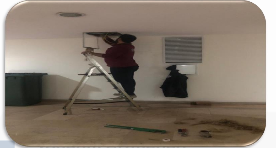
6.Kat ortak alan su hattındaki basınç düşürücünün değişimi gerçekleştirilmiştir.
