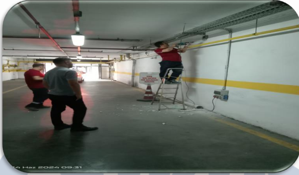
1 Kapalı otopark su toplama pimaş hattı kaçağı giderilmiştir.
