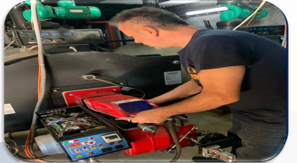
Isıtma sistemi periyodik bakım faaliyeti gerçekleştirilmiştir.
