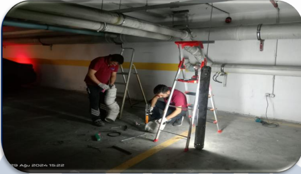
Yağmur suyu drenaj hattı giderleri güçlendirilmiştir.
