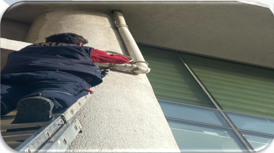
Çevre kablo düzenlemeleri gerçekleştirilmiştir.
