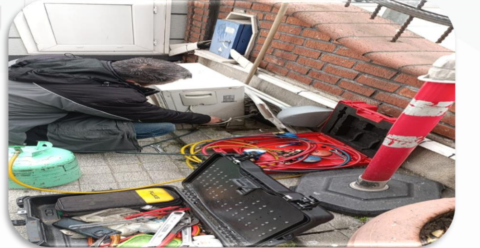
Güvenlik kabini klima arıza kontrolleri gerçekleştirilmiştir.
