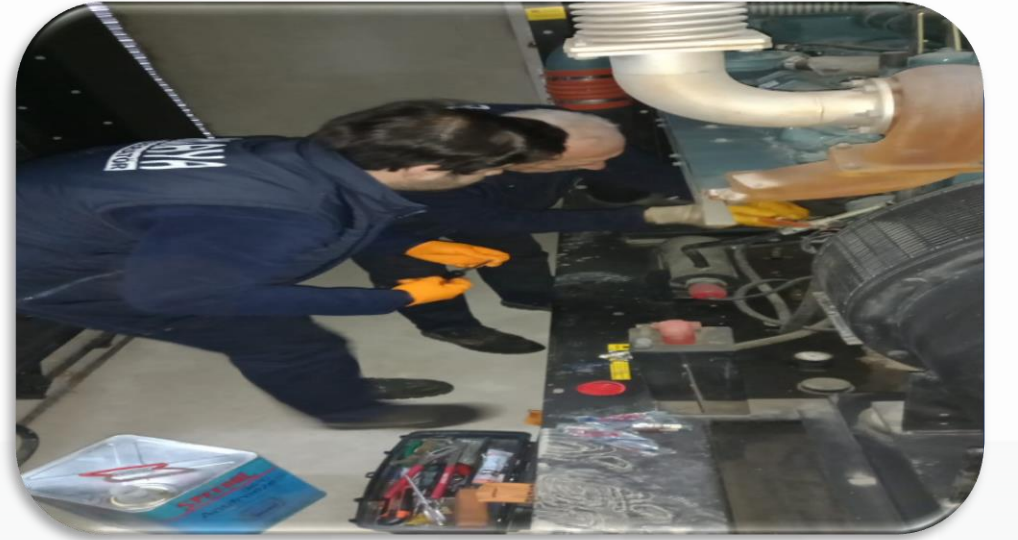
Jeneratörlerin su vanaları değiştirilmiştir.
