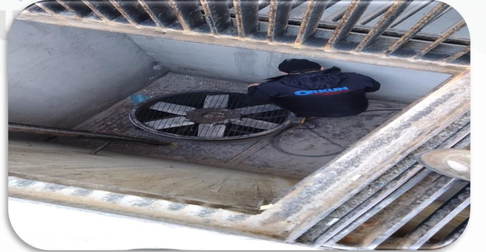
Havalandırma bořluęu ve mazgal temizlięi gerekleřtirilmiřtir.
